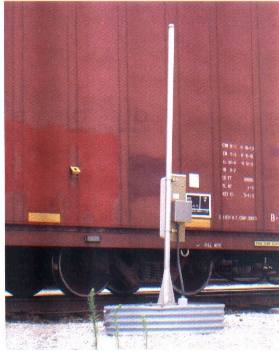
Con InTouch HMI il personale può inserire manualmente i dati nel sistema di supervisione da qualsiasi punto all'interno dello scalo, grazie a Wonderware Industrial Computers
