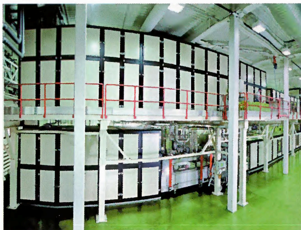
Un impianto di produzione del cioccolato basato su sistema di supervisione Wonderware, sviluppato da B&B Automation per OPM.
